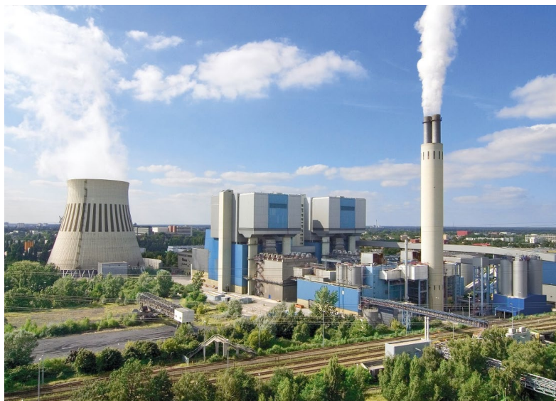
Das Heizkraftwerk Reuter West im Nordwesten von Berlin. (Bild: Vattenfall)
